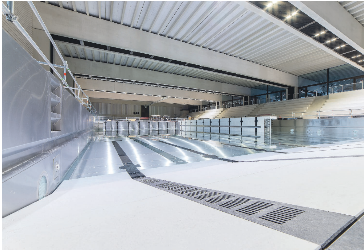
Das Becken im Campus ist eines von total fünf 50-Meter-Becken in der Schweiz.
